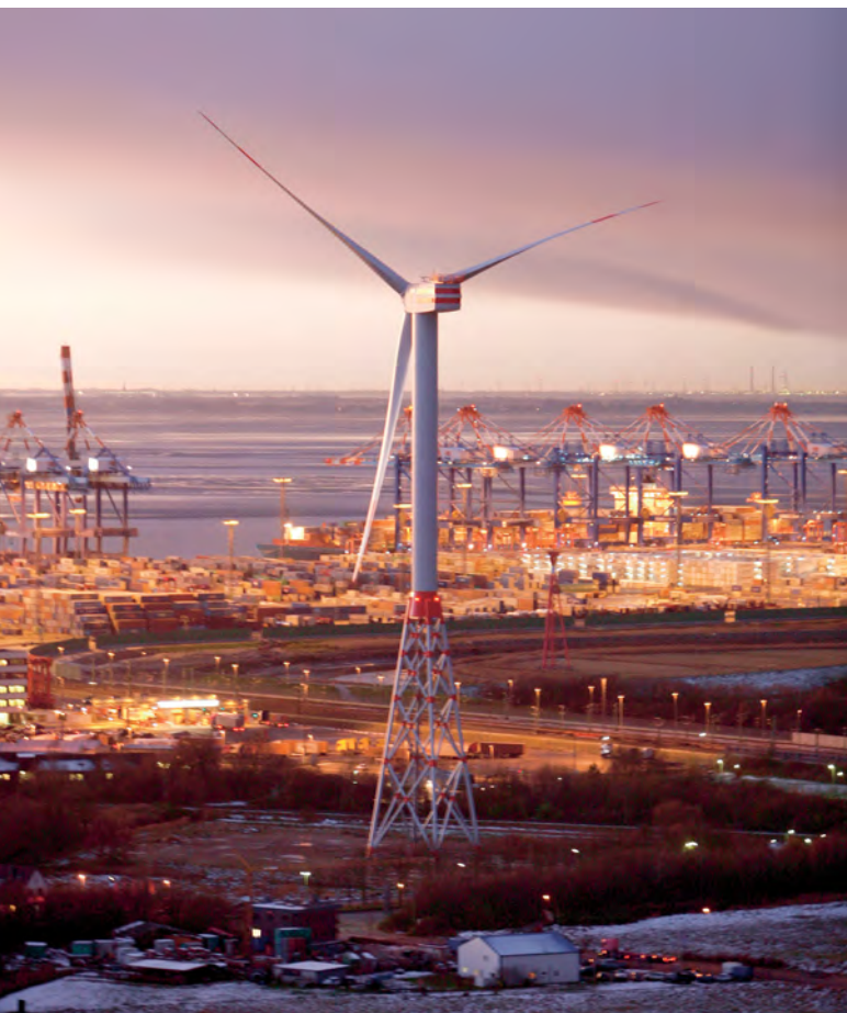
Offshore-Testanlage auf einem Jacket-Fundament in Bremerhaven-Speckenbüttel mit einer Leistung von 5 Megawatt
