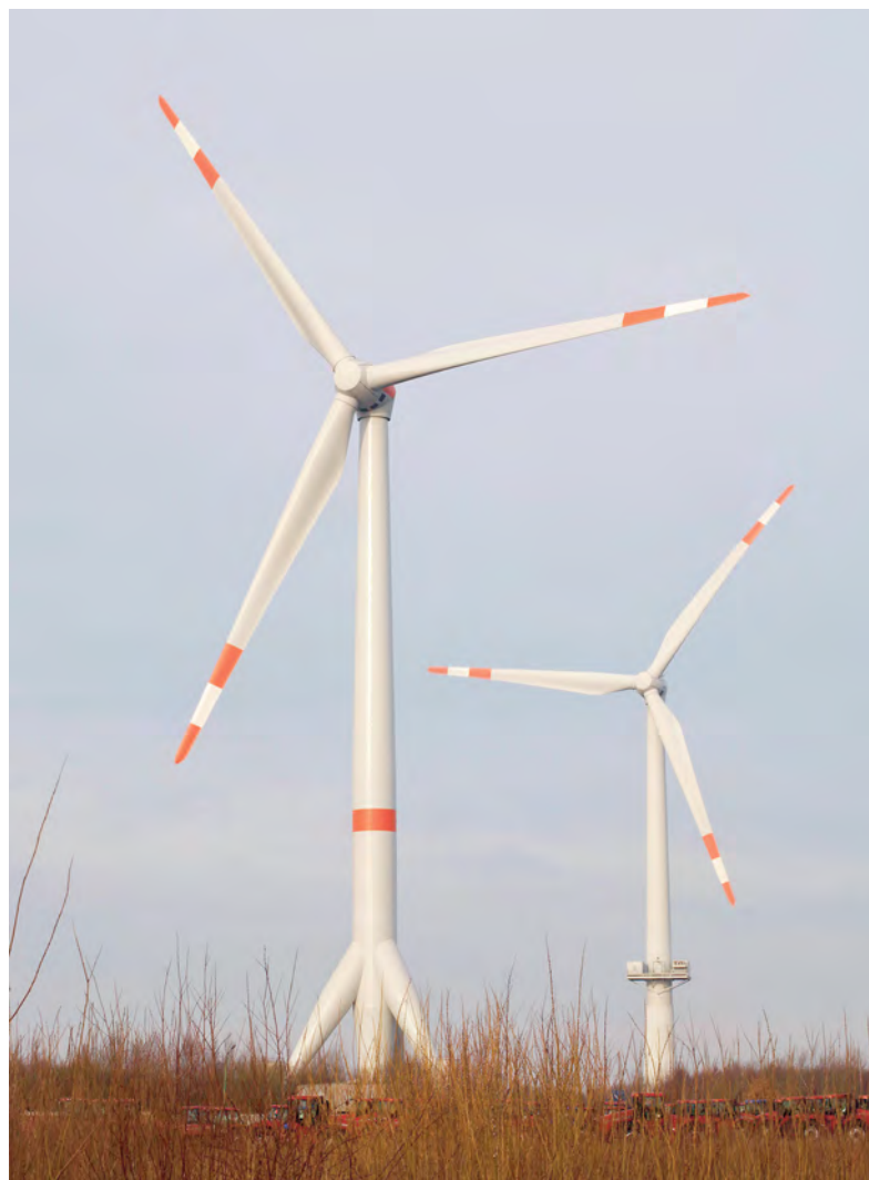
Offshore-Testanlagen in Bremerhaven-Speckenbüttel (vorn auf einer Tripod-Gründung) mit einer Leistung von jeweils 5 Megawatt
