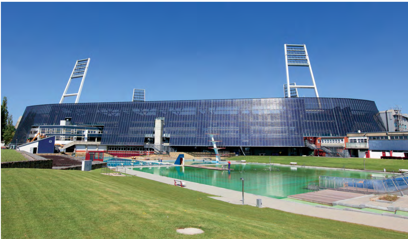
Photovoltaik-Anlage am Weser-Stadion mit einer Gesamtleistung von rund 1,2 Megawatt (peak)
