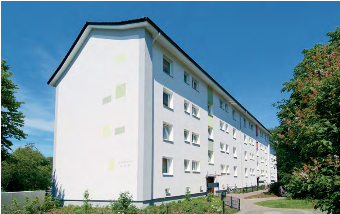
Mehrfamilienhaus in Huchting, das im Rahmen der Sanierung zu einem Niedrigenergiehaus umgewandelt wurde.
