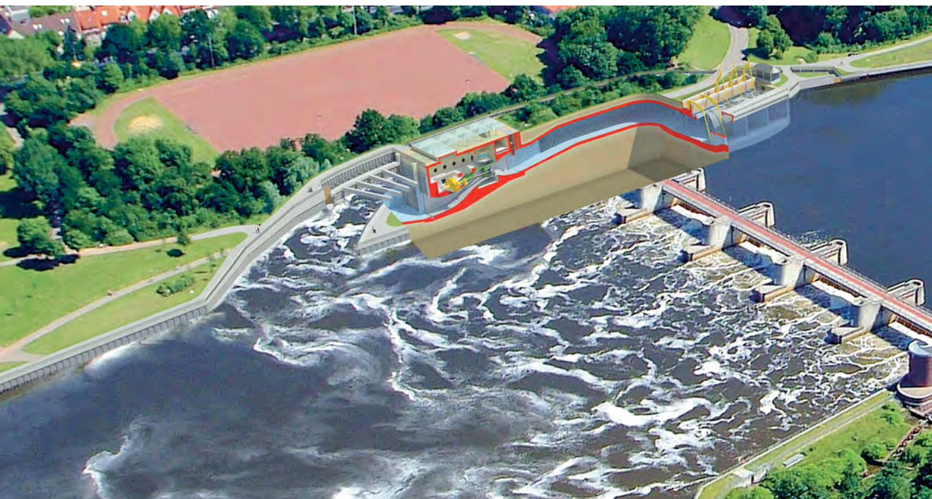
Computersimulation des künftigen Wasserkraftwerks am Weserwehr Bremen mit einer Leistung von rund 10 Megawatt. Mit seiner Fertigstellung wird das rot markierte Krafthaus überbaut sein.
