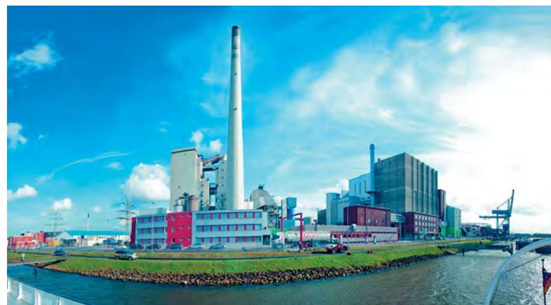
Die ökologische Modernisierung der Stromerzeugung bietet erhebliche CO 2 -Minderungspotenziale: Hier das Kraftwerk Hafen mit dem neuen Mittelkalorik-Kraftwerk
