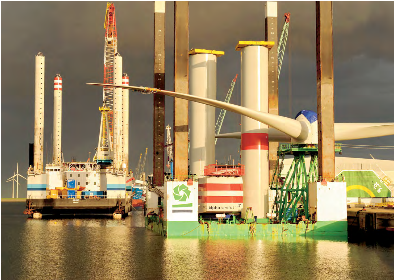
Errichtung einer 5-Megawatt-Windkraftanlage im Offshore-Windpark alpha ventus, September 2009
