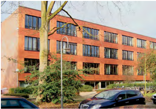
Bei der in 2008 abgeschlossenen Sanierung der Höheren Handelsschule an der Grenzstraße wurden die nach der EnEV 2007 zulässigen Höchstwerte um 30 % unterschritten.
